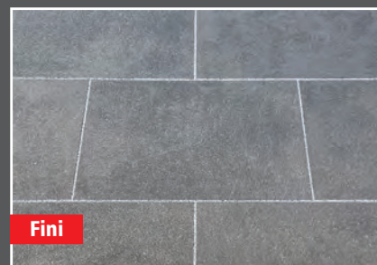
Nettoyage final balai gros
